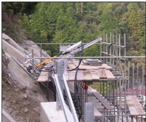
機械設置状況
