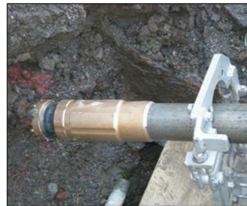
機械設置状況
