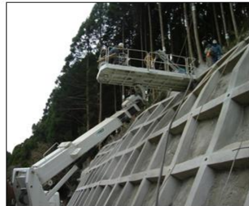
機械設置状況
