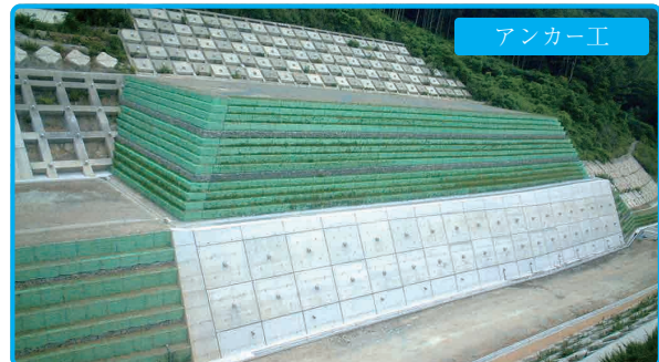
鉄筋挿入工
